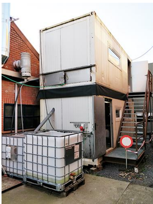
Foto : de prototype installatie die geïnstalleerd is in 2 mobiele containers op de site van Deknudt.
