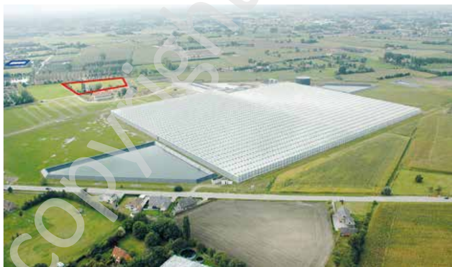
Glastuinbouwzone Stokstorm. Op de voorgrond de serre van Tomato Masters, in het rood het perceel waar ondertussen de viskwekerij van Aqua4C staat, in het blauw de serres van PCG waar de proeven voor het STOKSTROOM-project zullen doorgaan.
